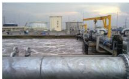
越南河内污水处理 污水处理厂 Yen So Park 处理河内污水 的 50%。安装了 90 多台变频器，其中 12 台 450 kW VLT® AQUA Drive 用于控制 风机。
